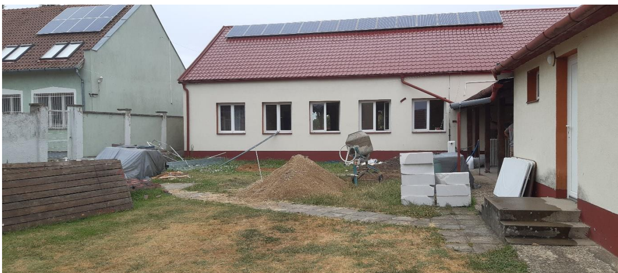
a művelődési ház hátsó homlokzata és a szomszédos könyvtár épület hátsókert felé néző homlokzata és a piac jelenlegi helyszíne ahová az új piacépület kerülne
